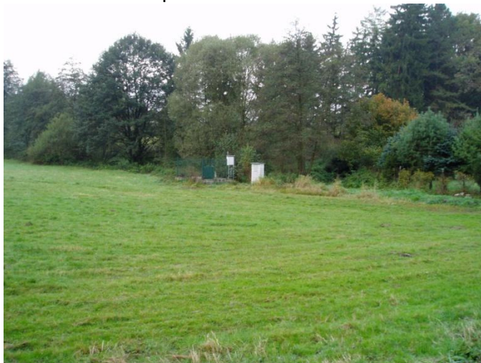
Obr.6. Čerpací stanice Dolní Bezděkov.
